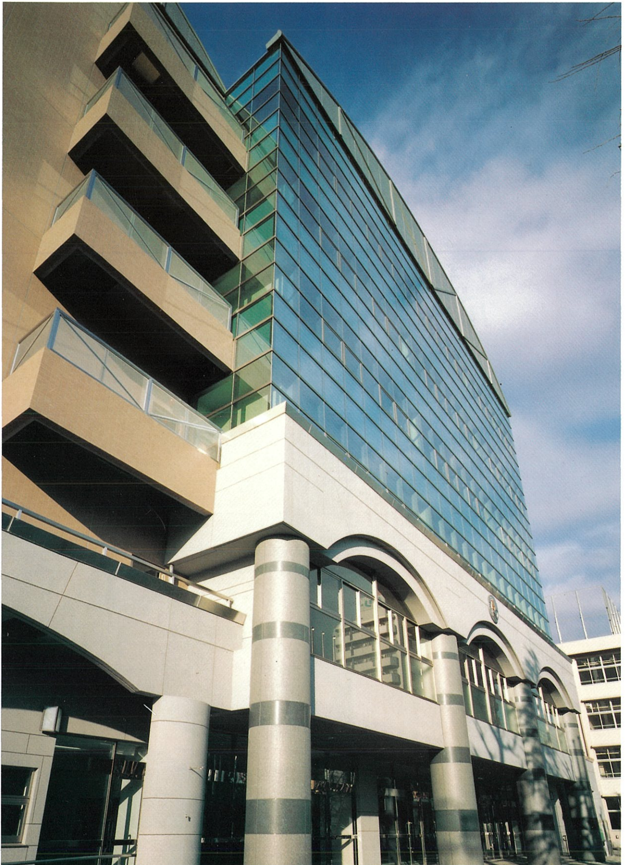
▲東面外観見上げ
